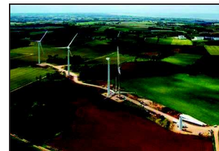
Photo 21 : Hisse et assemblage du rotor
