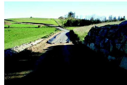
Photo 7 : Mise en place du gravier
