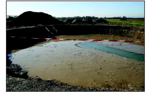
Photo 10 : Fouille de la fondation
