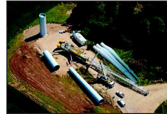
Photo 19 : Vue d'ensemble des étapes d'assemblage de la tour (exemple de tour en acier)
