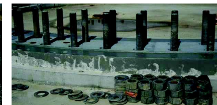
Photo 3 : Détail des fixations de la fondation
