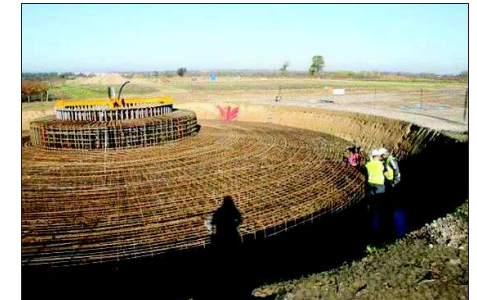
Photo 13 : Ferrailage de la fondation
