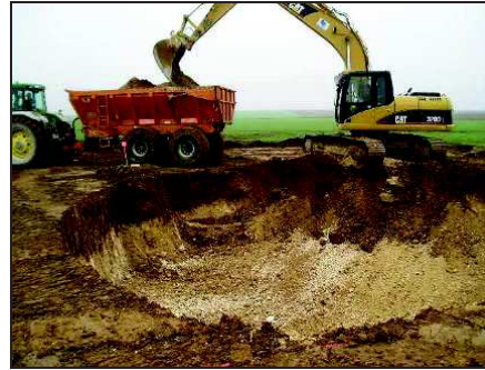
Photo 9 : Excavation de la fondation
