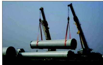
Photo 17 : Manipulation des tronçons d'éoliennes
