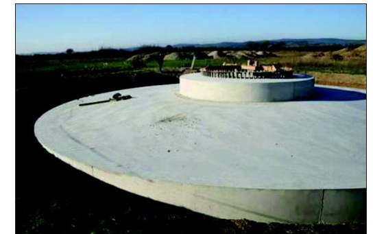
Photo 15 : La fondation terminée
