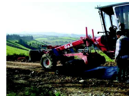
Photo 6 : Pose du géotextile
