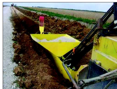
Photo 8 : Engin utilisé pour le creusement de la tranchée et la pose des câbles
