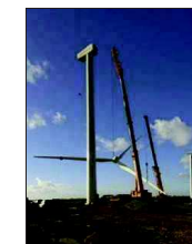
Photo 21 : Hisse et assemblage du rotor
