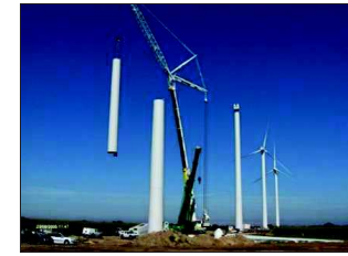
Photo 19 : Vue d'ensemble des étapes d'assemblage de la tour (exemple de tour en acier)
