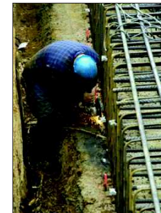
Photo 12 : Préparation des fondations
