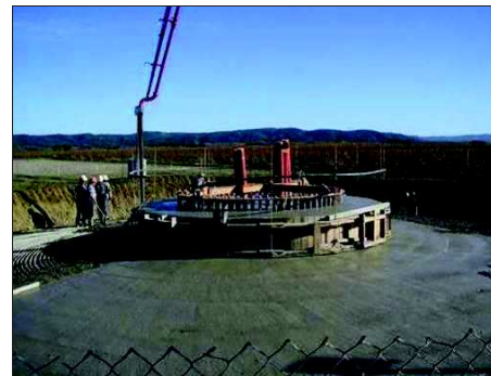
Photo 14 : Coulage du béton
